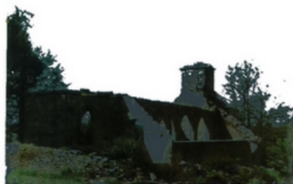
État de la chapelle en 1987 après le passage de l'ouragan Photo de M. Pierre Laversanne, Bannalec.
