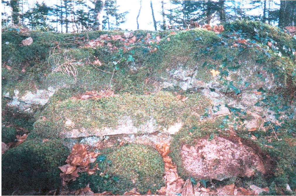
Photo 3: Fondations de la structure centrale n°12
