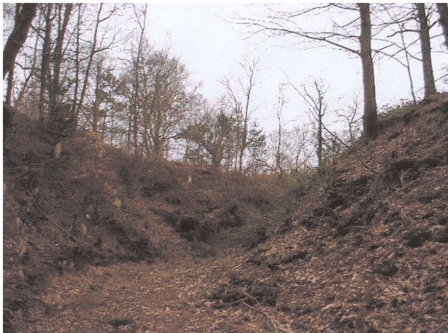
Photo 1: Douve nivelée au pied du mur n°3
