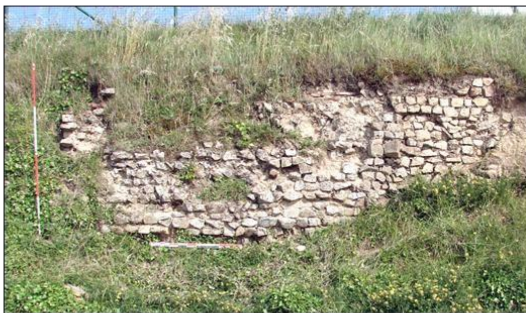
Figure 2 : Murs visibles en front de falaise
