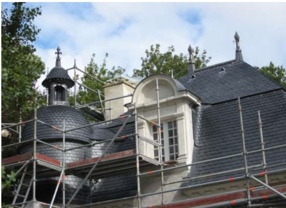
Couverture : pose des ardoises sur le pavillon et sur une des tourelles d'escalier La lucarne en tuffeau porte la date de 1669 Phot. Service valorisation du patrimoine – Ville d'Hennebont – Janvier 2009
