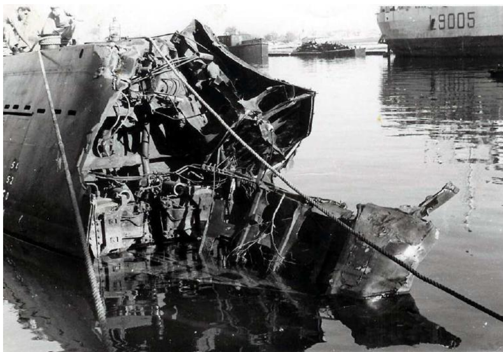
Charpente avant de l' Espadon après la collision – Collection Christian Lecalard.
