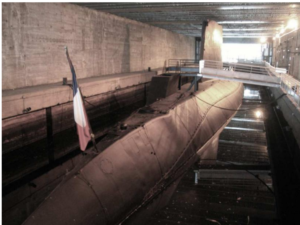
Espadon dans la forme-écluse à Saint-Nazaire Photo Jean-Yves Le Lan.
