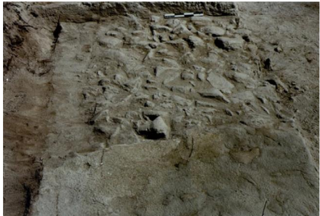
Fig13 Chaussée constituée d'un solide empierrement de moellons. Au premier plan état d'origine avec arène granitique dans les interstices. Au second plan après décapage de l'arène granitique. DRAC. RAPO 1468 1997
