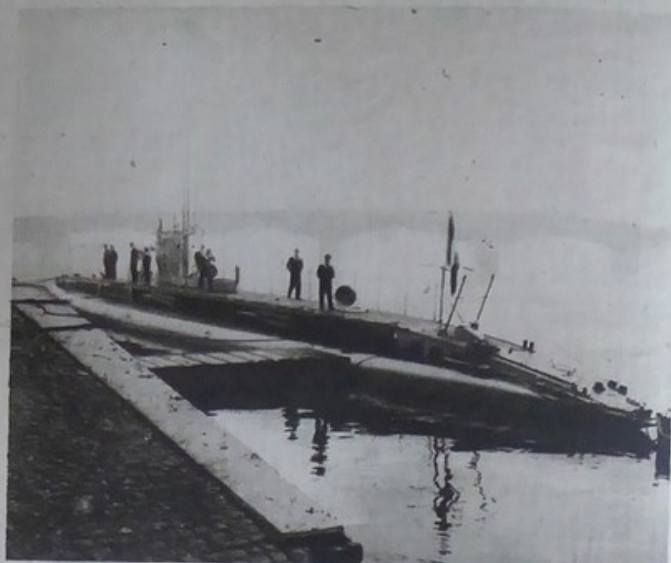
Le sous-marin « Montgolfier », qui est amarré au pont de la Concorde, est un submersible Laubeuf; il déplace 398 tonnes; sa longueur est de 51 m. 12 et sa largeur de 4 m. 97. Il fait 12 nœuds en surface.
